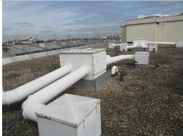
*Circuit aéraulique en toiture-terrasse (bâtiment E) avec caisson d'extraction quadruple ouïe d'aspiration*
