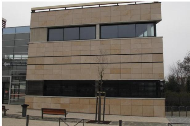
Exemple de polystyrène sous enduit avec bossage imitation maçonnerie de pierre de taille classique :
